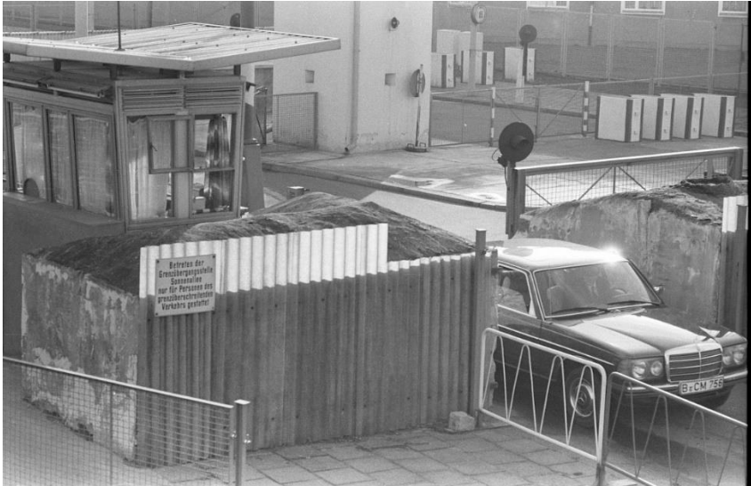
PKW durchquert Grenzübergangsstelle Sonnenallee Foto: Edmund Kasperski
